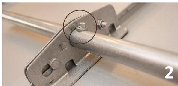
1. Fest en konsoll i hver ende ved å tre de to underdelene som henger sammen, over falsen uten å feste de. Tre så den øvre delen ned mellom de to. Justér og trekk til skruene med 40 Nm, slik at konsollen klemmes godt fast i falsen. Bruk en snor mellom konsollene for å få en rett linje, og monter deretter resten av konsollene i rekken.
